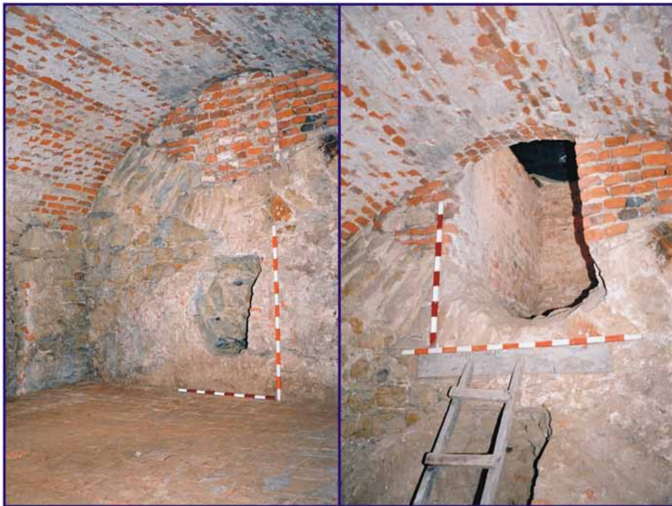
Ryc. 11. Widok na przemurowania otworu wejściowego w północnej ścianie krypty środkowej – po lewo i odsłonięty korytarz w kierunku nawy głównej – po prawo (fot. R. Niedźwiadek)
