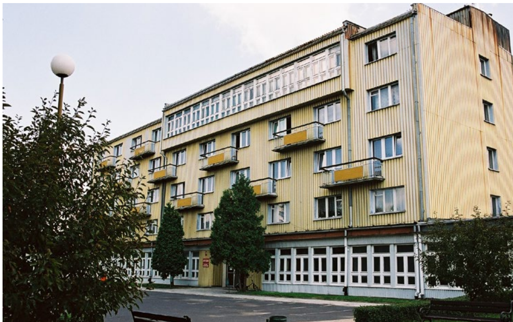
Budynki Zamiejscowego Wydziału Ekonomiki Produkcji i Obrotu Rolnego Akademii Rolniczej im. Hugona Kołłątaja w Krakowie, kampus w Rzeszowie-Zalesiu.
